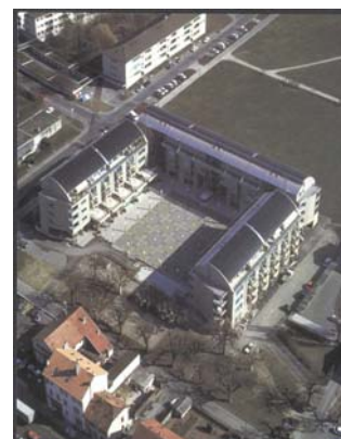
La plus grande Cité solaire de Suisse à Genève avec ses 227 appartements et ses 1'700 m2 de toitures solaires a été réalisée par G. Spöhrle. Chaque capteur et chaque radiateur sont équipés de la vanne de réglage MAXI'QUITUS .
